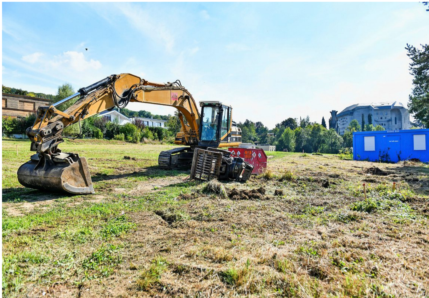
«La Colline»: Die Bagger waren schon auf dem Platz, da verhängte das Bundesgericht den Baustopp, der bereits nicht mehr gilt. Foto: Pino Covino
