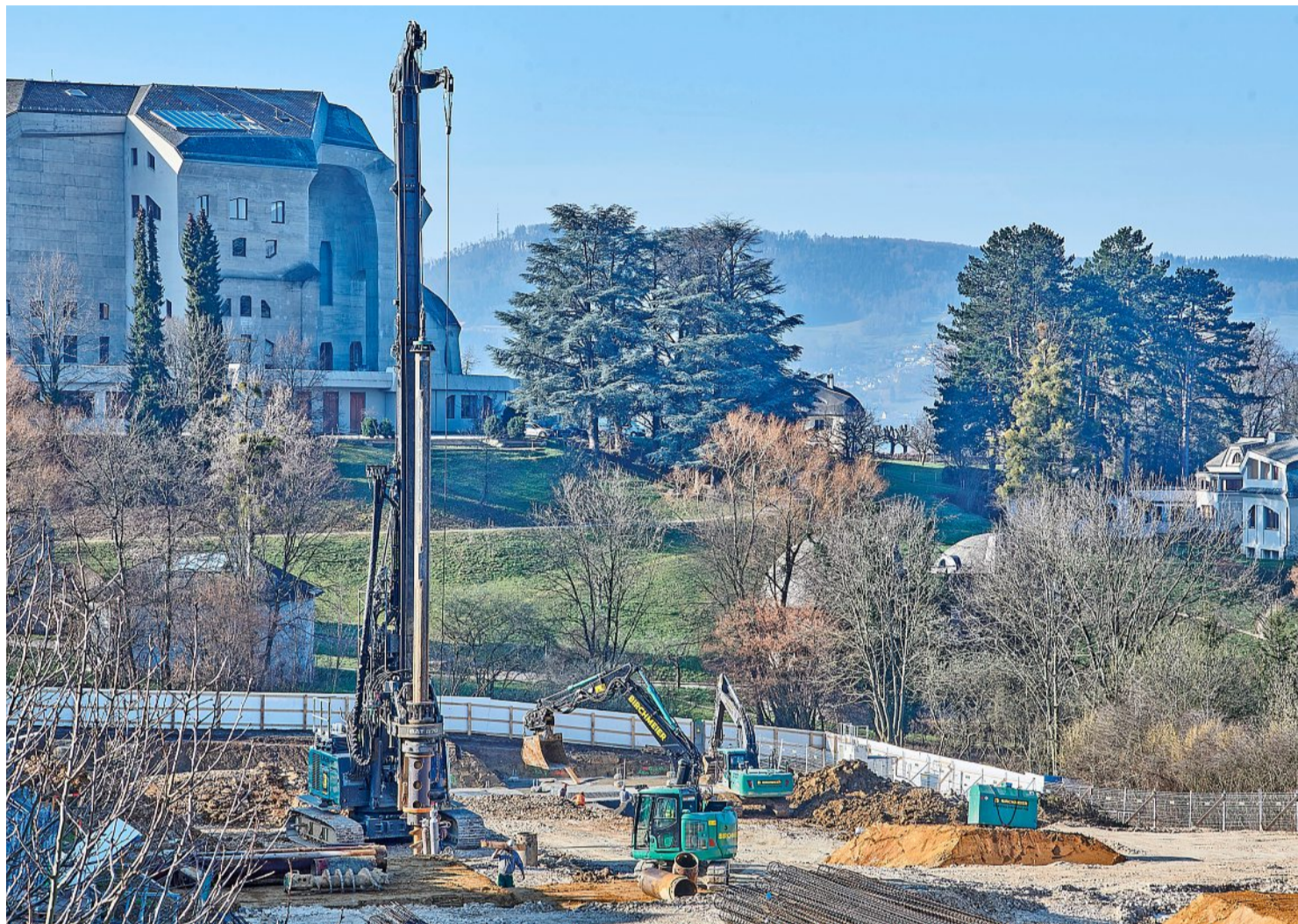
Während über den Schutz des Feuchtgebiets geredet und geredet wird, gehen die «La Colline»-Bauarbeiten weiter. Foto: Christian Jaeggi
